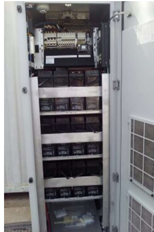
Batteries & Rectifier Modules
